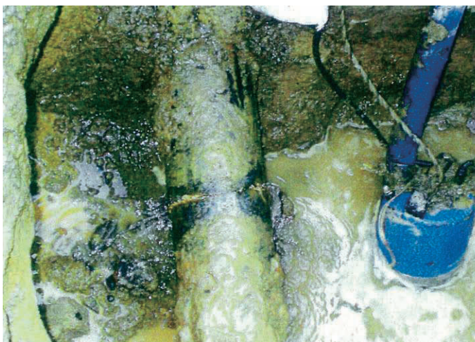
写真 4.79 配水管被災状況
