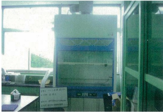
ダクト連結部地震動で破損
