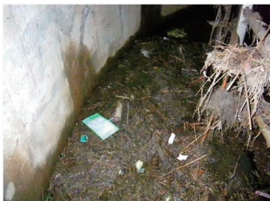
写真 2.9 浅井戸の津波被災例 (岩手県陸前高田市竹駒第1水源地)
