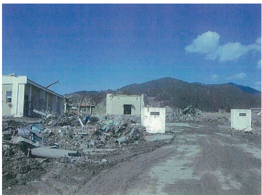
被災した水源地（浅井戸）全景（中央の建物が取水施設、左側が電気室で津波で屋根まで冠水、電気室の屋根に流木）
