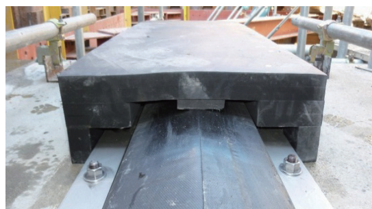
写真-3 伸縮目地部
