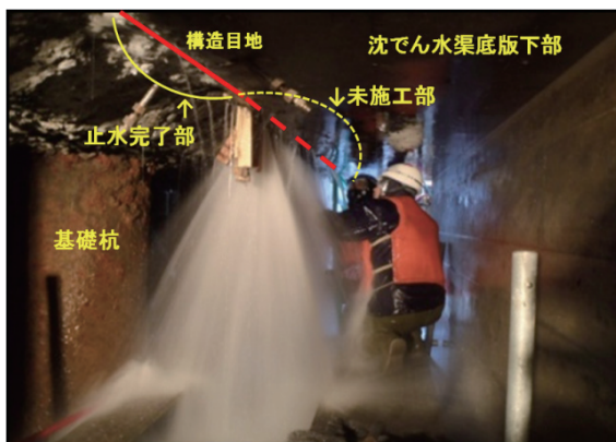
写真-1 止水作業状況(施工中)
