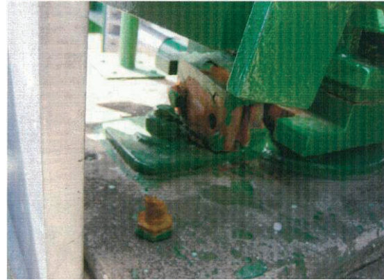
写真 4.111 水管橋被災状況（橋脚沓破損）
