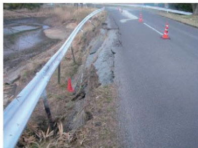
町道路肩崩落による脱管(山元町大平地内 DIP φ400 K形) 復旧状況(NS形で復旧)
