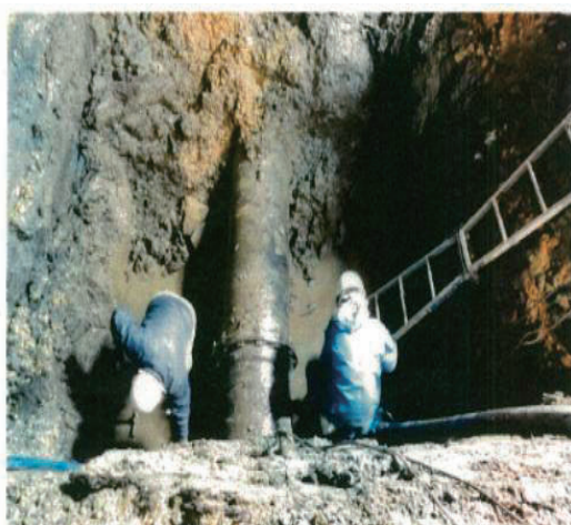
写真 4.107 被害と復旧状況 (大崎広水～中峰浄水場構内・大崎市古川地内)
