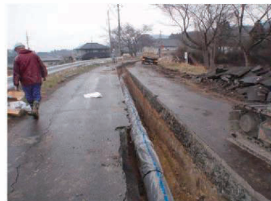
町道路肩崩落による脱管(山元町大平地内 DIP φ400 K形) 復旧状況(NS形で復旧)
