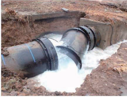
伸縮可撓管抜け落ち2カ所(白石I.C付近 SP φ2400)
