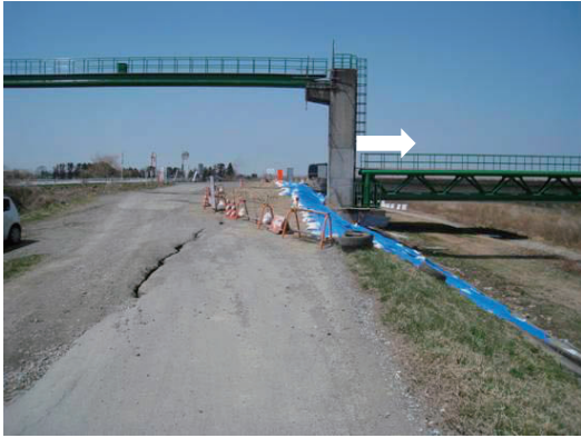
橋脚の河川側への移動（大崎）
