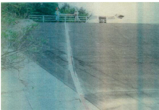
写真 4.96 南川ダム(ロックフィル)垂直方向に亀裂状況
