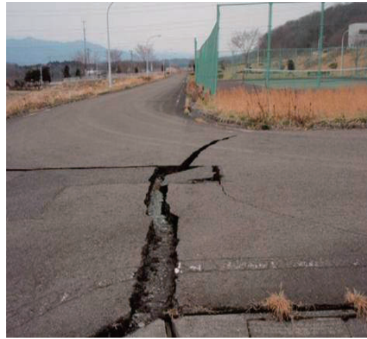
写真 4.94 中峰浄水場 場内道路亀裂状況
