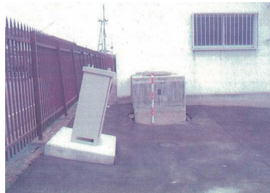
電気防食設備（引込柱・引込開閉機盤・計器盤・直流電源装置・ケーブル類は、地震動及び地震動に伴う地盤沈下により傾斜・破損）
