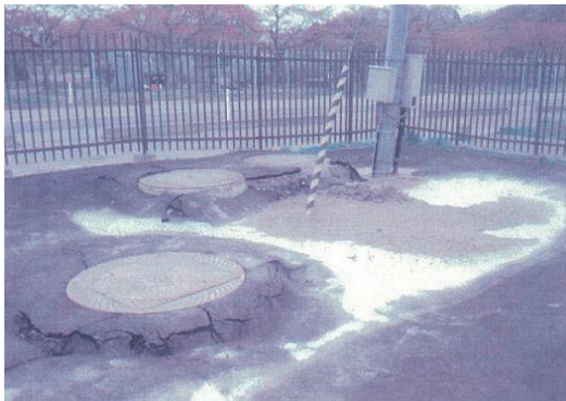
電気防食設備（引込柱・引込開閉機盤・計器盤・直流電源装置・ケーブル類は、地震動及び地震動に伴う地盤沈下により傾斜・破損）
