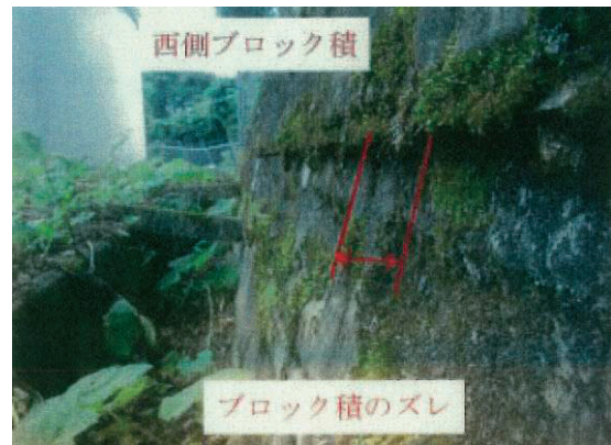
写真 4.97 ブロック積擁壁の亀裂・天端の崩壊状況
