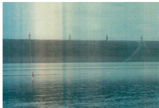
写真 4.96 南川ダム(ロックフィル)垂直方向に亀裂状況
