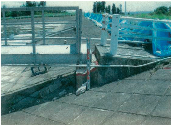
写真 4.95 中峰浄水場 管理橋橋台桁座破損状況
