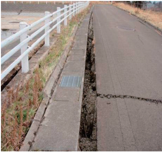
写真 4.94 中峰浄水場 場内道路亀裂状況
