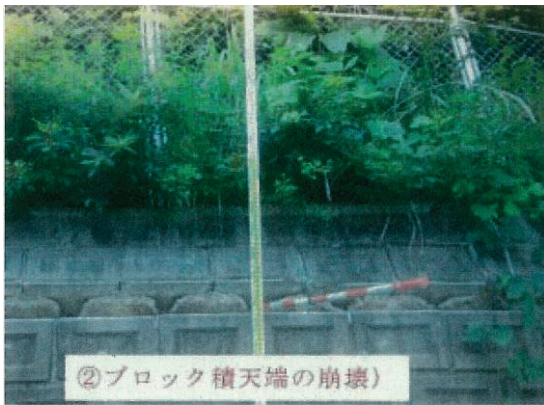
写真 4.97 ブロック積擁壁の亀裂・天端の崩壊状況
