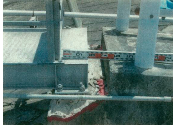
写真 4.95 中峰浄水場 管理橋橋台桁座破損状況
