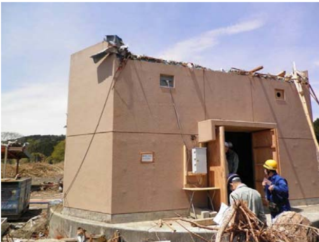
■ 取水ポンプ室（浅井戸）
