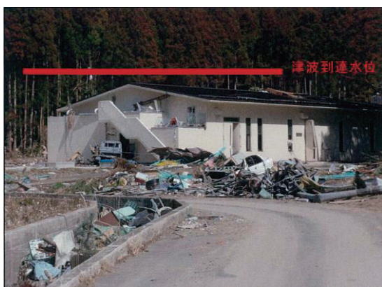
津波被害状況
