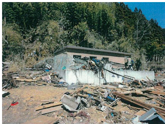
写真 4.57 相川浄水場被災状況（全景）
