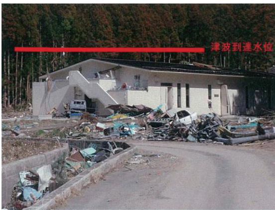
大浜浄水場全景 (津波は屋根を越えた)
