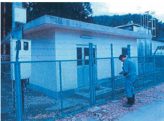
ポンプ場全景
