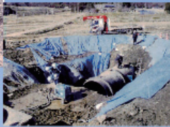
県広域水道φ2400の修繕状況
