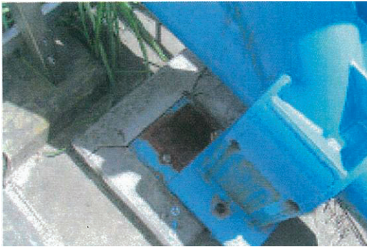
橋台の損傷
