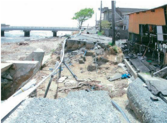
久之浜地区津波被害
