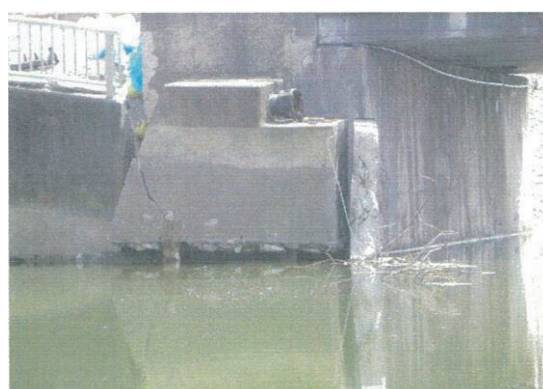
橋台の損傷
