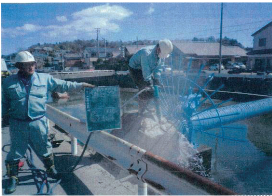
写真 4.124 水管橋被災状況（小名浜下町地内） φ400
