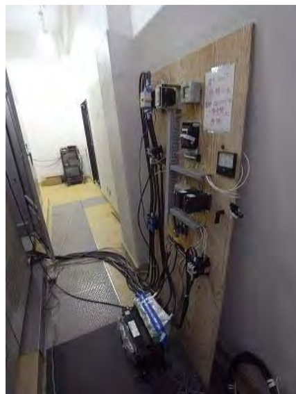
写真 3.7 津波被害後の仮設動力盤の設置例（岩手県山田町折笠第1水源地）
