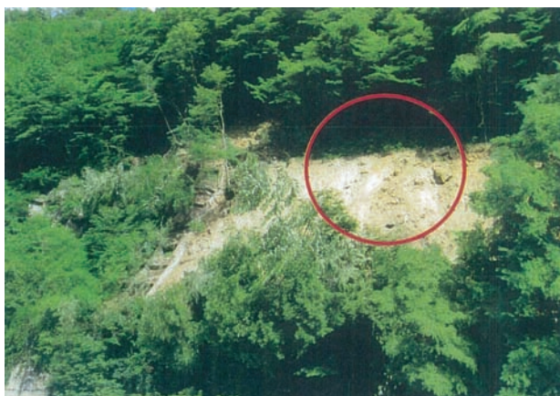
写真 4.13 水源地の崩落 (浅布・小川原飲料水供給施設)
