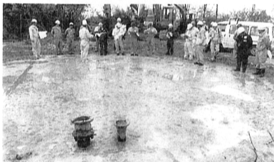
沢配水池（一関市）跡地で説明を受ける
