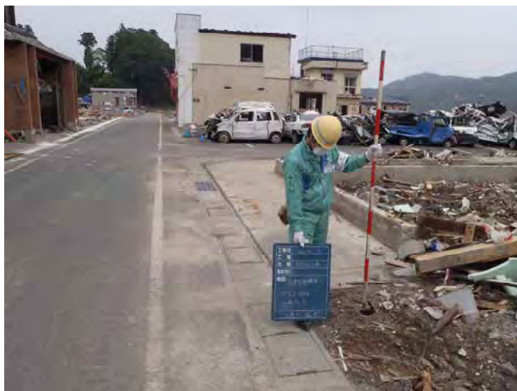
写真 3.17 家屋流出後の給水栓閉止作業（岩手県大槌町）
