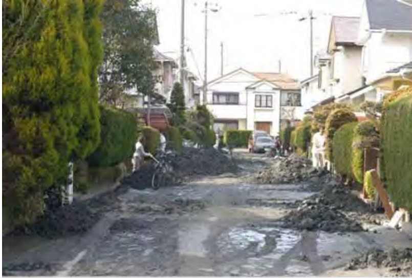
写真 3.11 液状化の状況(千葉県幕張地区)
