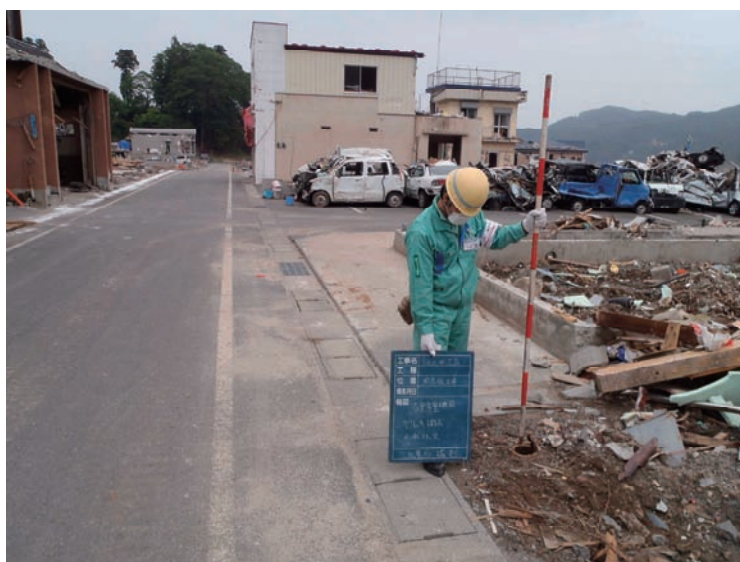
写真 2.23、2.24 家屋流出後の給水栓閉止作業（岩手県大槌町）
