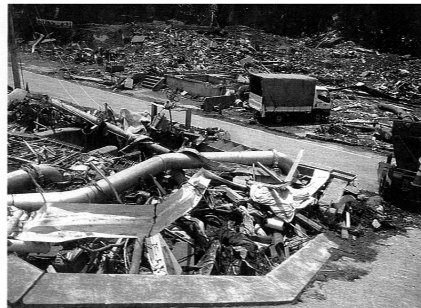
津波により市街地が壊滅した陸前高田市。かれきの上に仮設配管を布設し水道通水を急ぐ
