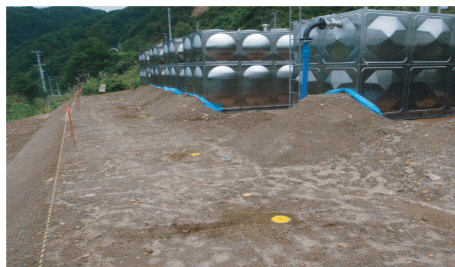
写真5.3 仮設配水池設置状況 （石渕簡易水道）
