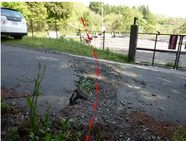
■鷹ノ巣浄水場災害状況（H23.4.11の余震（M7.0）で発生した地表地震断層による被害）
