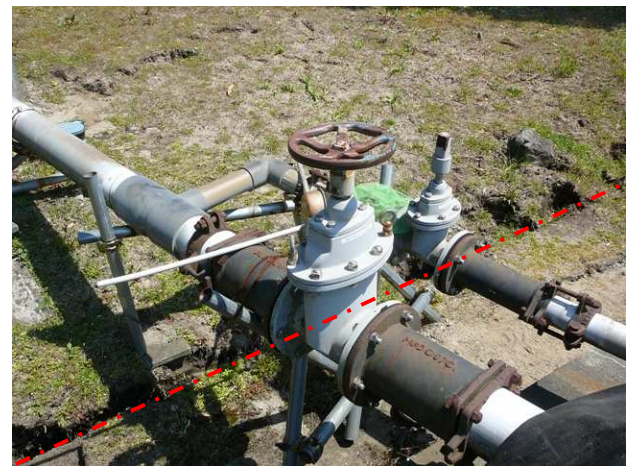
■鷹ノ巣浄水場災害状況（H23.4.11の余震（M7.0）で発生した地表地震断層による被害）
