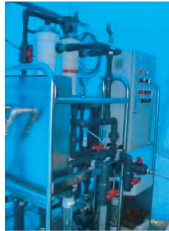
写真 5.8 栗原市花山大笹・荒谷簡易水道（花山地区） 仮設簡易膜ろ過ユニット設置状況
