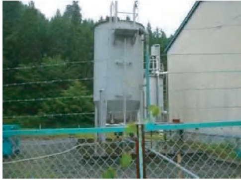
写真 5.7 栗原市文字簡易水道（栗駒地区）前処理ろ過機（市所有）
