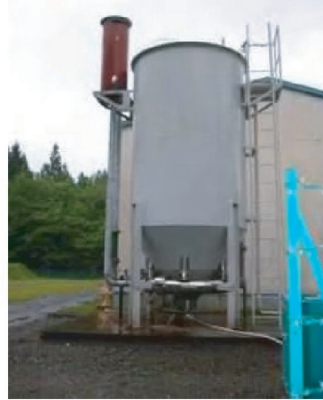
写真 5.7 栗原市文字簡易水道（栗駒地区）前処理ろ過機（市所有）
