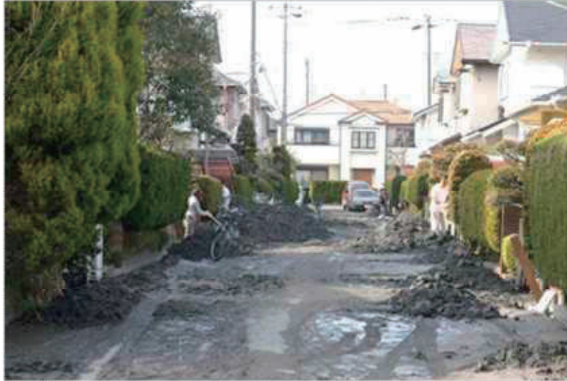
写真 2.17 液状化の状況(千葉県幕張地区)
