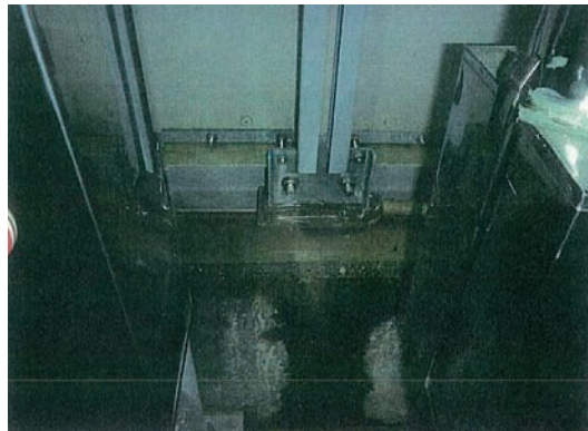
消石灰沈降槽（パネルタンク）破損・漏水（4箇所/槽）
