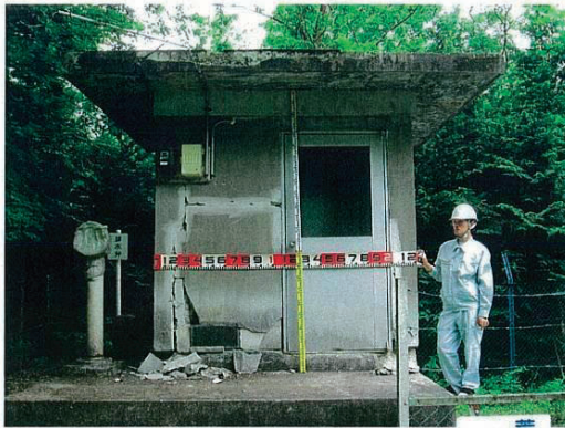
写真 4.86 荒谷配水池滅菌室（鉄筋コンクリート造） 構造損壊
