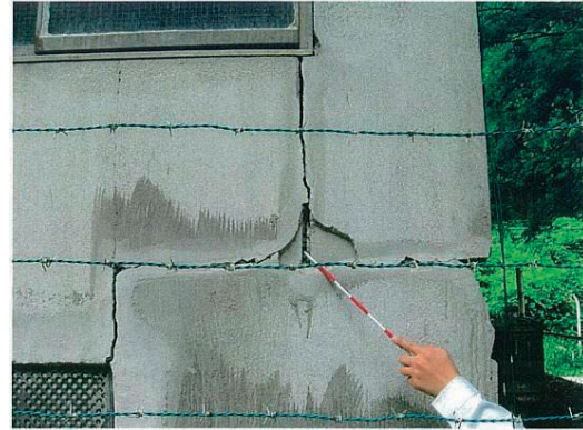
写真 4.86 荒谷配水池滅菌室（鉄筋コンクリート造） 構造損壊
