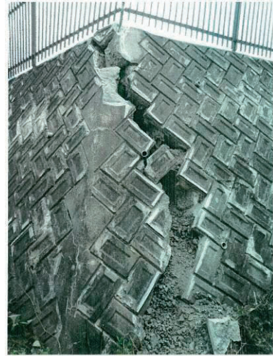
写真 4.85 有賀配水池場内舗装・擁壁 被災状況
