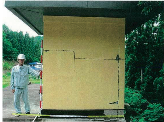
写真 4.87 越戸浄水場滅菌室（コンクリートブロック造） 構造損壊
