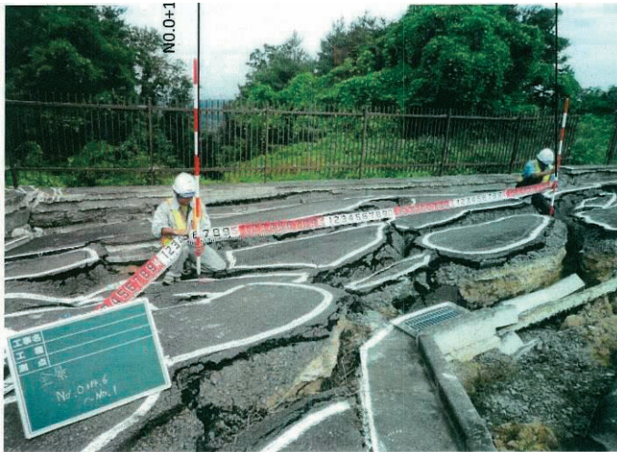
写真 4.85 有賀配水池場内舗装・擁壁 被災状況
