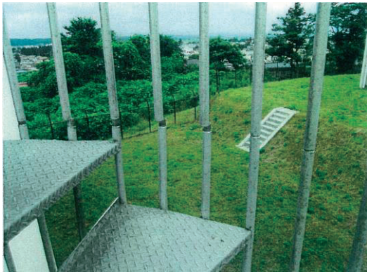
写真 4.88 薬師ヶ丘配水池螺旋階段被害（安全柵の抜け）
