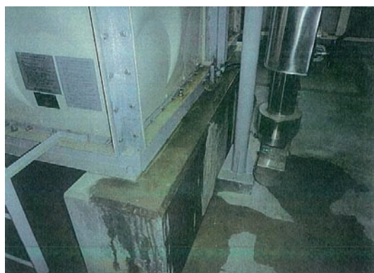
消石灰沈降槽（パネルタンク）破損・漏水（4箇所/槽）
