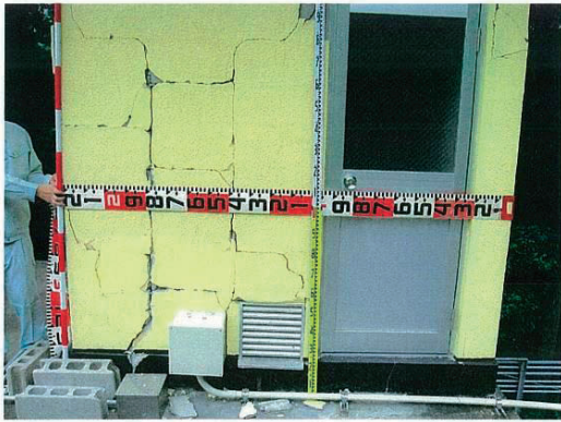
写真 4.87 越戸浄水場滅菌室（コンクリートブロック造） 構造損壊
