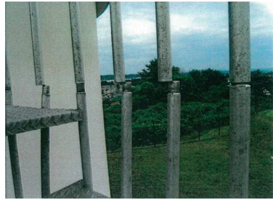
写真 4.88 薬師ヶ丘配水池螺旋階段被害（安全柵の抜け）
