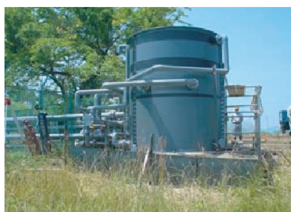
写真 5.5 衣川簡易水道ろ過機設置状況
