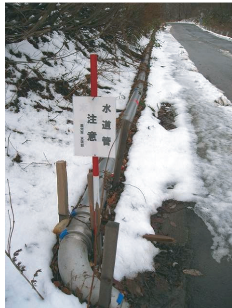
写真 3.3 緊急連絡管の布設 (胆沢地区)
