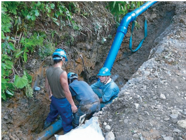
写真 3.2 応急復旧作業の様子
