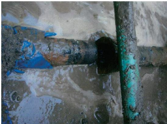
DIP φ75 継手破損
