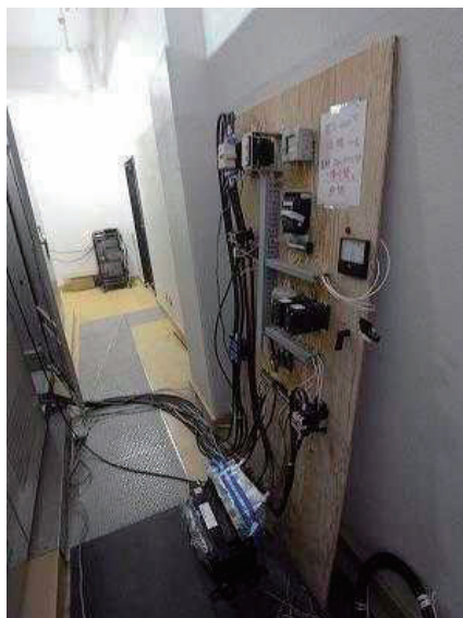
写真 2.12 津波被害後の仮設動力盤の設置例（岩手県山田町折笠第1水源地）
