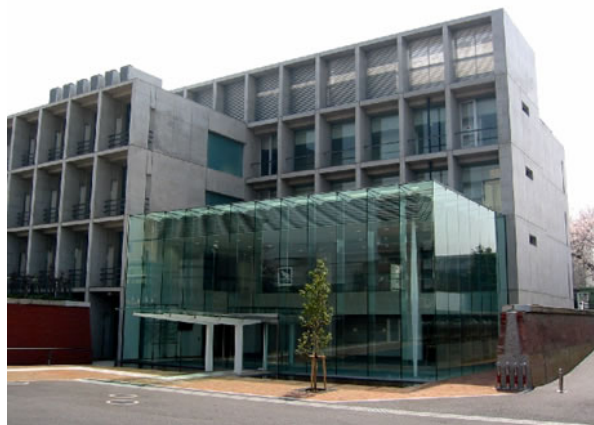
東京都水道局研修・開発センター
