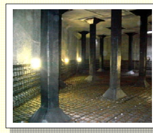
補強工事の実例
