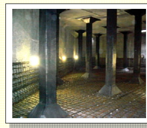
補強工事の実例
