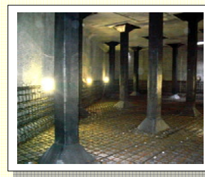
補強工事の実例
