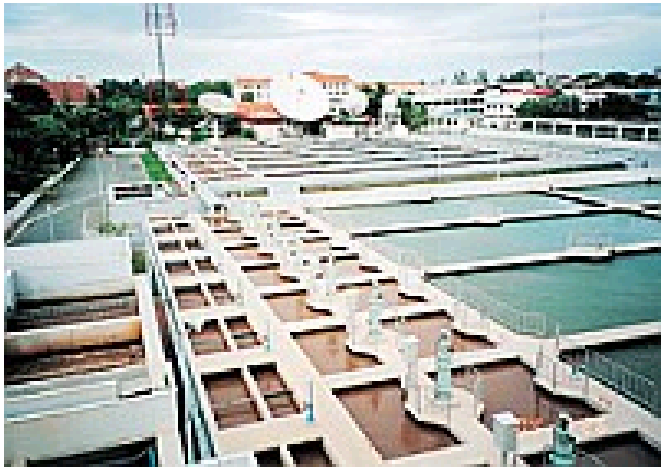
日本の協力で拡張・改修された プンプレック浄水場(カンボジア)
