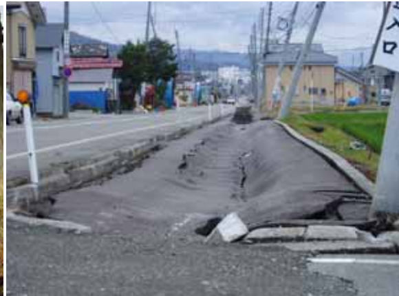
写真 5.7 マンホール浮上,歩道の陥没(小千谷市桜町)
