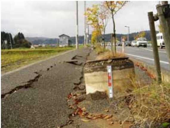
写真 5.6 マンホール浮上,歩道の陥没(小千谷市若葉町)
