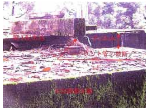
図 4.7 中央簡易水道 第3配水池の被害概要
