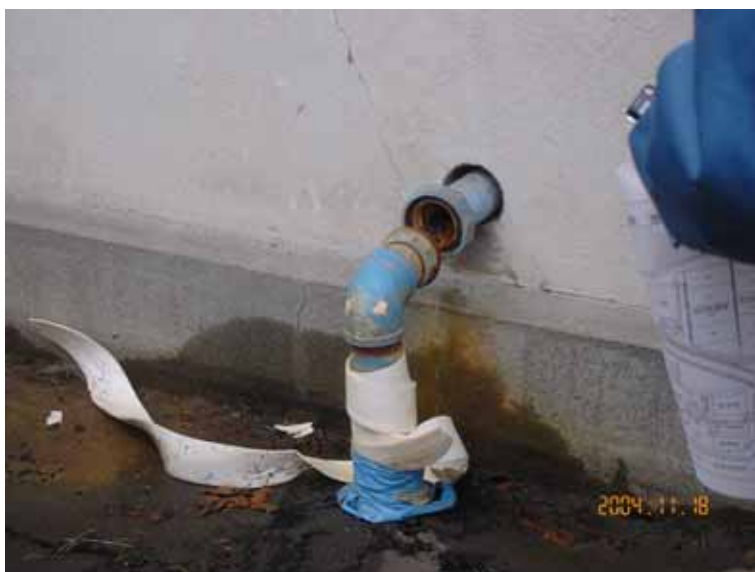
写真 4.4 構造物との取り合い部での配管
