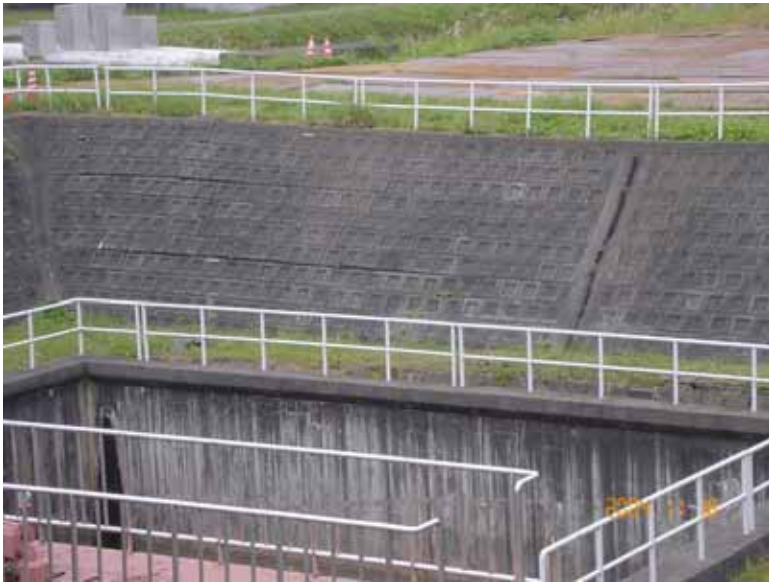
写真 4.5 排泥池付近のブロック 積擁壁
