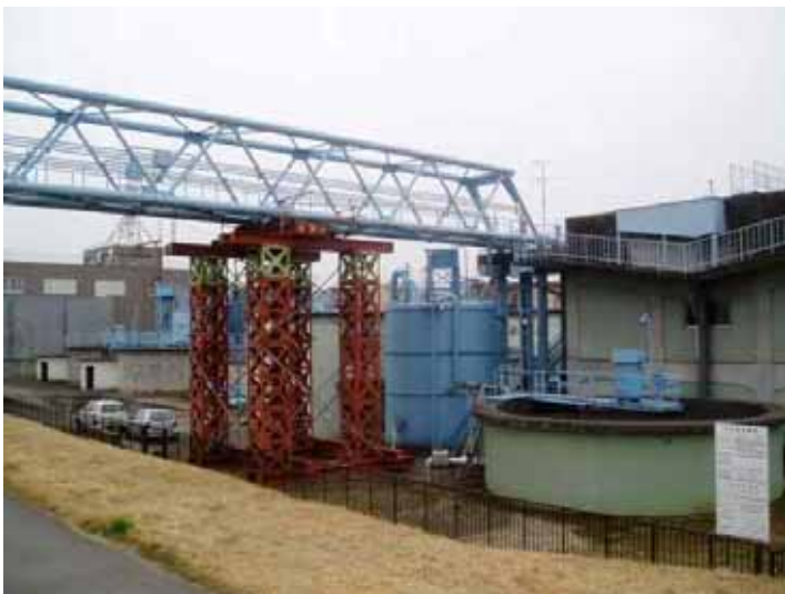
写真 4.8 水管橋の仮設桁による応急処置
