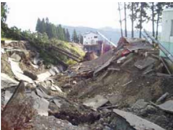
写真 4.12 塩殿浄水場の被害
