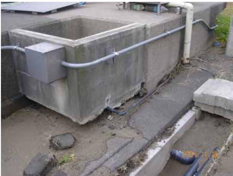
写真 4.3 附帯構造部分での沈下
