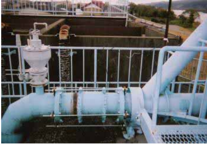
写真 4.9 支承部の破損
