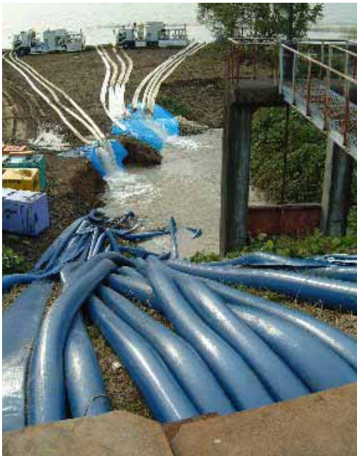
写真 3.4 妙見浄水場取水施設の仮設配管
