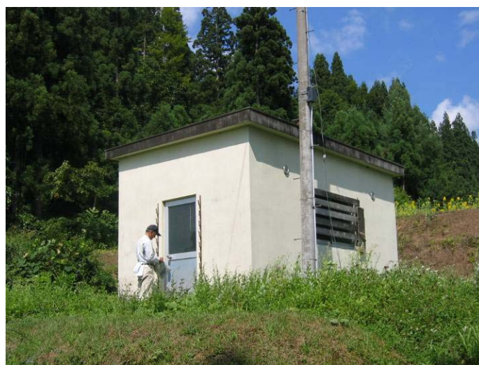
図 2-3-4 上野簡易水道配水池
