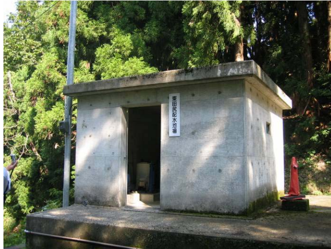
図 2-3-2 東田尻配水池
