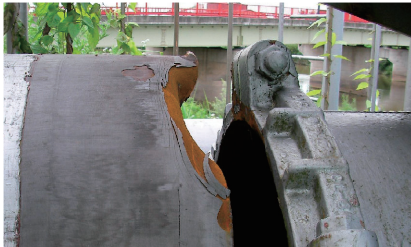
写真 5.13 伸縮管部の抜き出し状況
