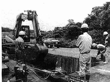
被害を受けた導水管の取替工事(17日午前、柏崎市赤坂町地内)
