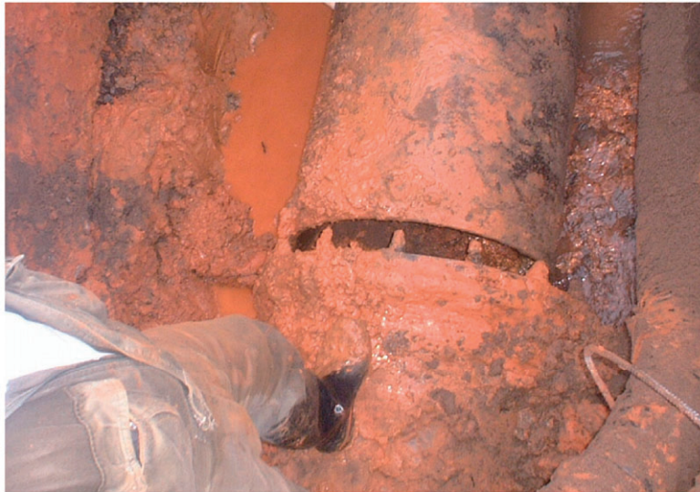
写真 5.2 赤坂山浄水場 \phi 600mm 逆洗管継手抜き出し状況
