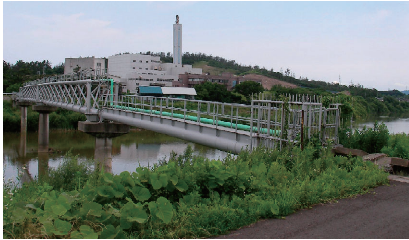
写真 5.12 柏崎市水管橋全景
