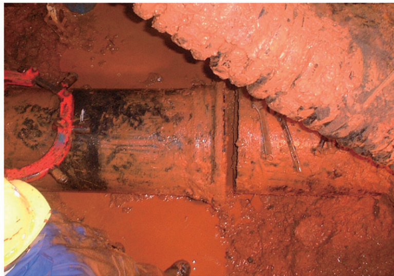
写真 5.3 赤坂山浄水場 \phi 450mm 表洗管継手抜き出し状況
