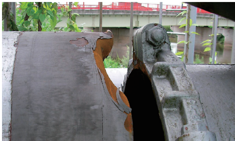
写真 5.13 伸縮管部の抜き出し状況
