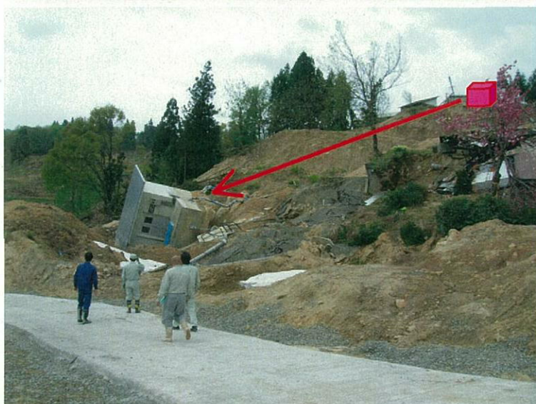
写真 5. 6 斜面崩壊により滑落した 第 5 中継ポンプ場（元の 位置からの滑落状況）
