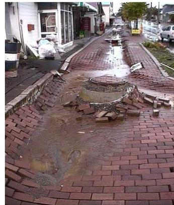
●管渠の被害（破損・たるみ）：新潟県中越地震
