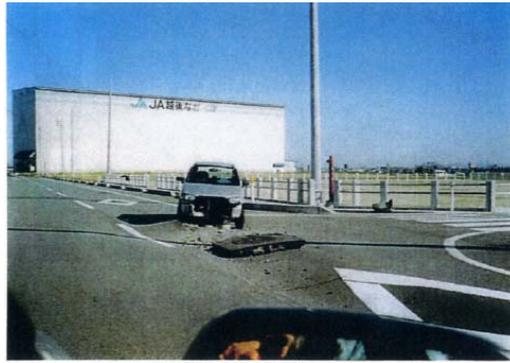
●管廻りの埋戻し砂の液状化に伴う道路陥没：新潟県中越地震
