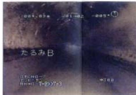
●管渠の被害（継ぎ手ズレ・取り付け管：新潟県中越地震）
