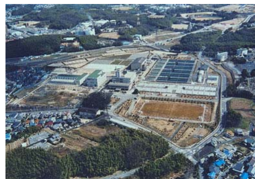
豊野浄水場 （大阪市水道局HPより）
