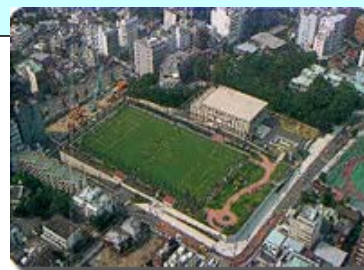
給水所の整備・補強（芝給水所）
