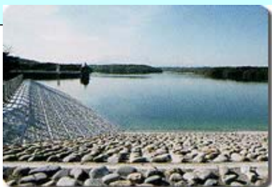
堤体強化工事（山口貯水池）
