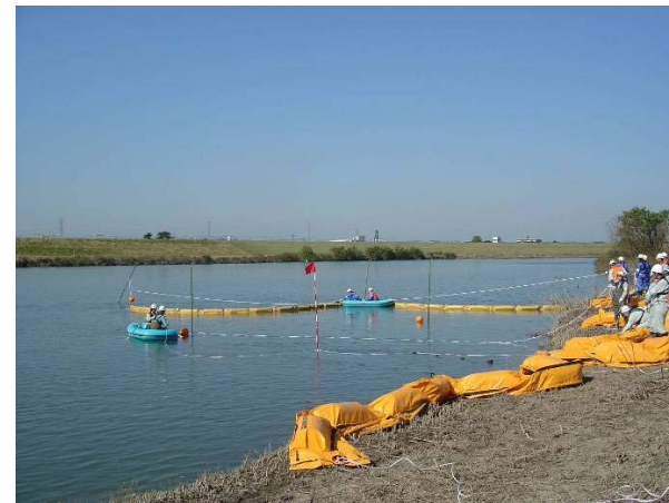
大河川における油流出事故対策(斜め展張)
