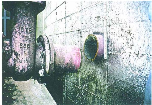
●処理場の被害（護岸側方流動）：兵庫県南部地震/東灘STP
