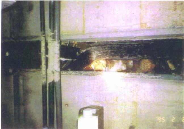
●処理場の被害（消化タンク地盤沈下、配管破断）：兵庫県南部地震/東灘STP
