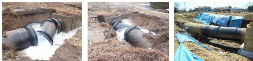
鋼管φ 2400可撓管の離脱と溶接による仮復旧(白石市内)
