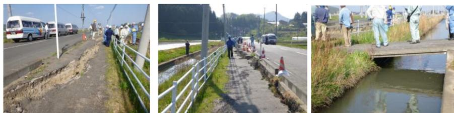
ダクタイル鉄管φ 900S形埋設現場の地盤変状(柴田町)
