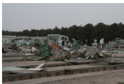
津波で大型ポンプなどの施設が壊れた県南浄化センター＝3月20日、岩沼市
