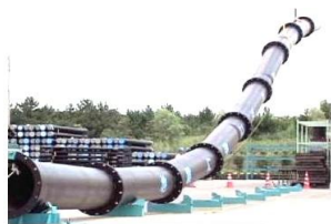
離脱防止機構付き継手(NS形)ダクタイル鉄管の吊上げ試験 提供:ダクタイル鉄管協会
