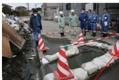
マンホールからあふれ出た汚水の応急措置＝3月28日午後2時40分ごろ、多賀城市大代地区
