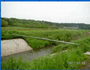
DIP 水管橋(被害なし)
