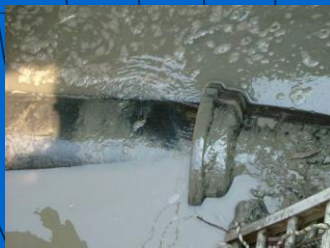
蛇田浄水場新下沼 φ500印籠継手の漏水
