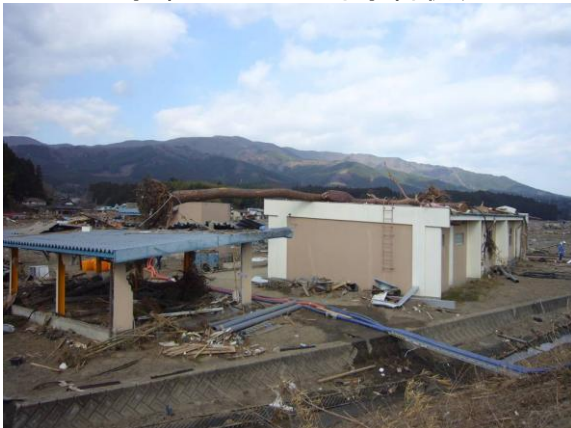
水中ポンプによる水替状況
