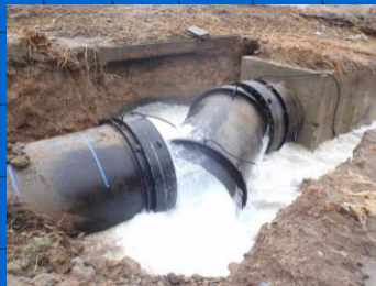
φ2400 鋼管 可とう継手の離脱
