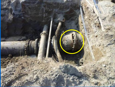
(φ600 ダクタイル鉄管 K形継手の離脱)
