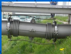
可とう管の破損
