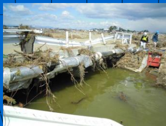
DIP NS形φ350 橋梁添架管 (被害なし)
