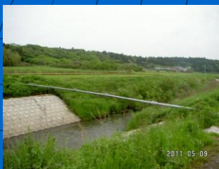
DIP 水管橋 (被害なし)
