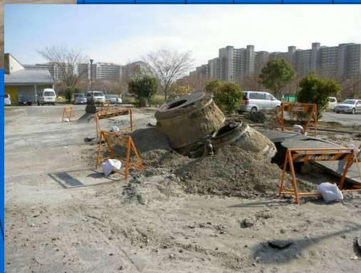
耐震貯水槽φ 2600 100t 鋼製
