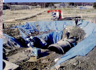
県広域水道 \phi 2400 の修繕状況
