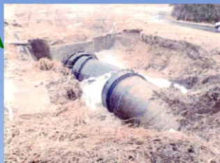
県広域水道 \phi 2400 の破損状況
